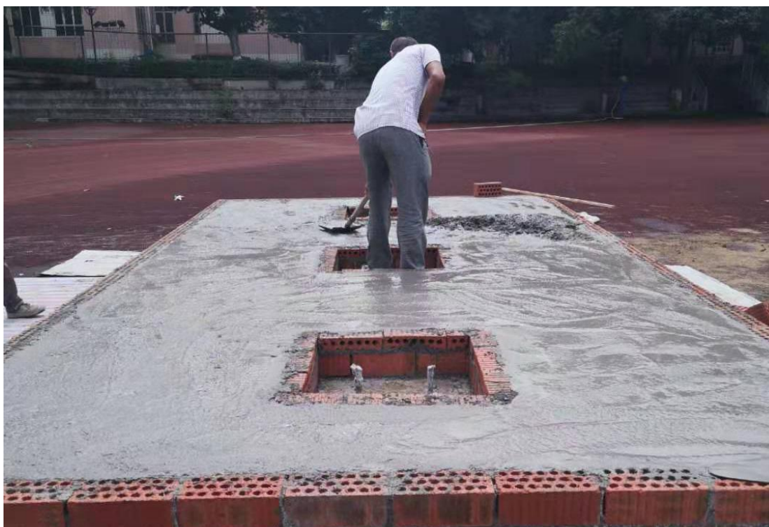
图片上正方形为预留的安装旗杆的位置，预留位置长 0.6 米，宽 0.6 米，高 0.2 米
